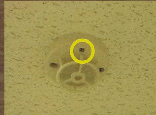
差動式スポット型熱感知機
