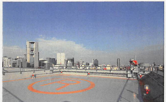
緊急救助用スペース(屋上)
