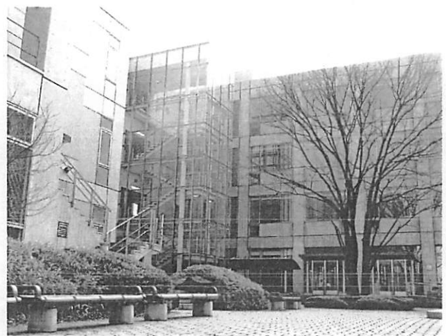
テラス広場から西館●West Building
