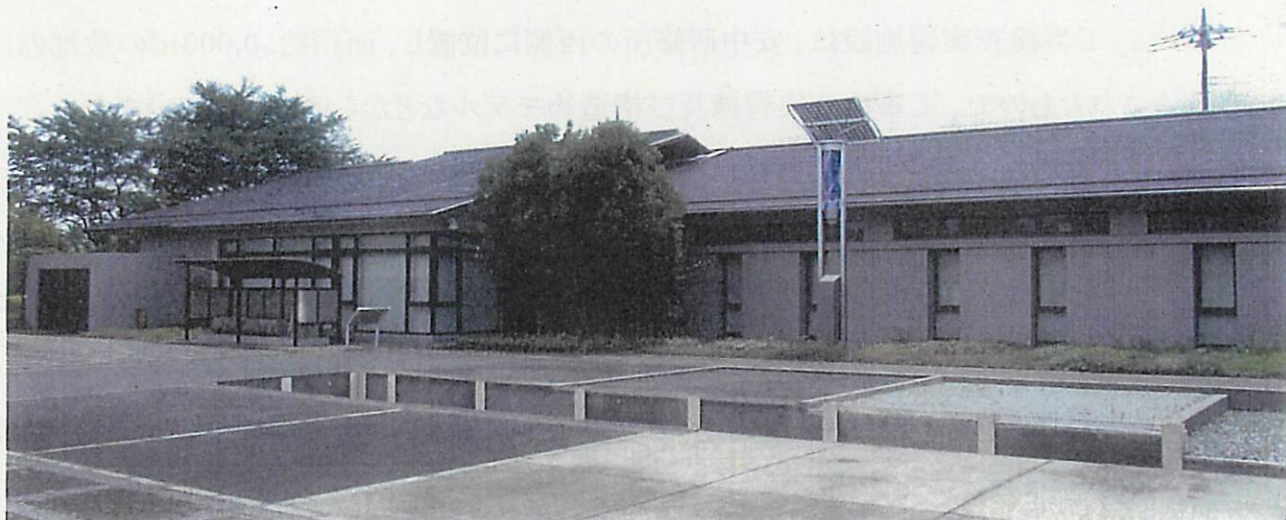
① 工事検査実習棟全景
